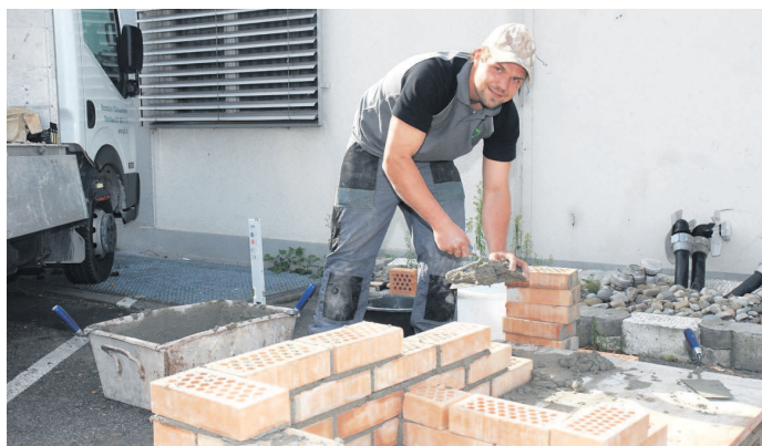
Yannick Riedo zeigt, wie ein Mauerwerk aufgezogen wird.
